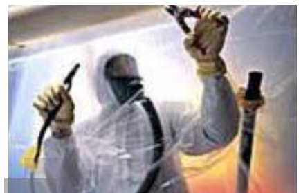
Dépose de calorifuge amianté dans un sac à manche
