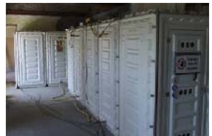
Sas de décontamination - Hôpital de Machecoul (44)
