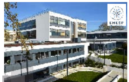
Réhabilitation et extension du bâtiment école / administration EHESP (35)
